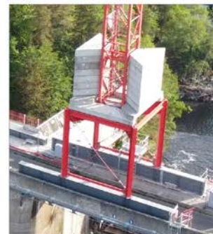
Bei Obendreher wird auf dem Fundamentkreuz der Zentralballast gestapelt, um den Schwerpunkt des Krans zu senken.
