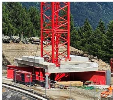
Bei Obendreher wird auf dem Fundamentkreuz der Zentralballast gestapelt, um den Schwerpunkt des Krans zu senken.
