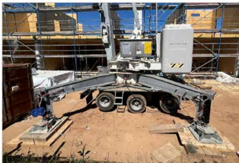
Abstützkreuz mit Holz-Unterbau am Unterwagen eines Untendreher
