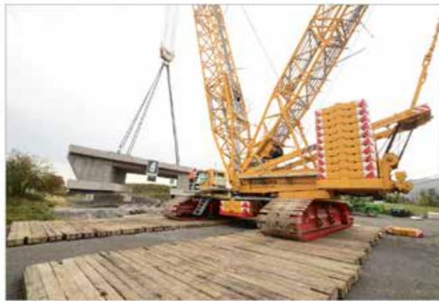
Großflächig ausgelegte Holzbohlen unter einem Raupenkran als Fahrweg
