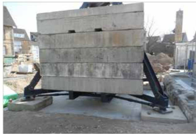
Gegossenes Fundament + Unterlegplatten unter einem Turmdrehkran
