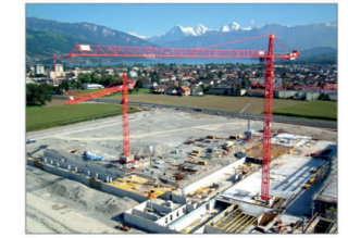
Obwohl auf festem Fundament stehend, ist ein Turmdrehkran ortsveränderlich. Vor der eigentlichen Kranarbeit müssen diese Krane erst ordnungsgemäß errichtet werden.
