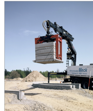
Einsatz einer kraftschlüssigen Steinklammer. Darunter wäre ein Aufenthalt noch gefährlicher.
