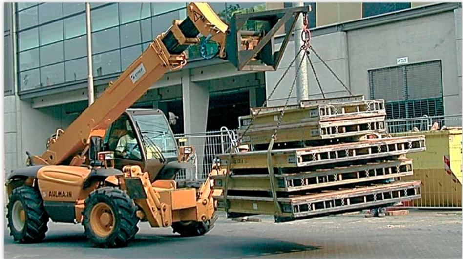
*Bei der Fahrt auf unebenem Gelände entstehen durch den Hebeleffekt des Vorbaus erhebliche **Zusatzkräfte**. Mindestens eine Tragfähigkeitsstufe (Nennstärke) dicker auswählen!*
