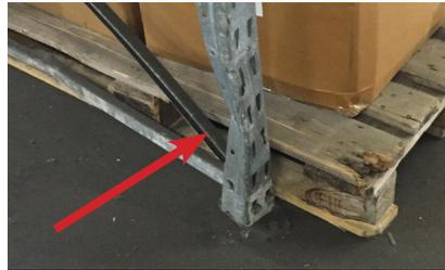
Schwere Beschädigungen an Regalen führen zu einer roten Gefahrenstufe nach DIN EN 15635.
