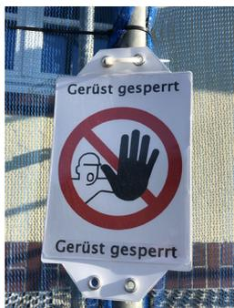
Defekte Gerüstbeläge, unsichere Aufstiege, lockere Verankerungen oder ein fehlender Seitenschutz führen zur Gerüstsperrung.
