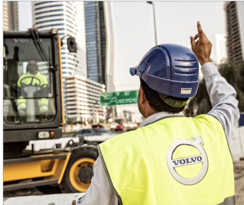
Zeichen zum Anheben an Baggerfahrer
